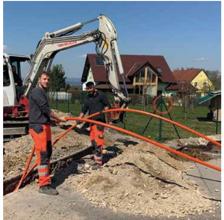
Arbeiter der Fa. Strabag beim verlegen der LWL-Leerrohre
