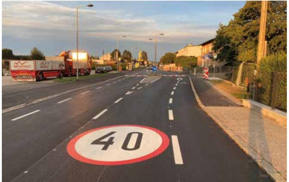
Rückbau der Mauthausner Straße in Windpassing.
