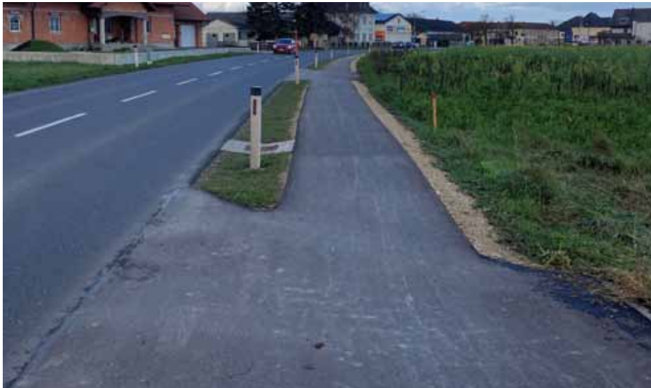
Der neue Gehweg in der St. Valentin Straße.
