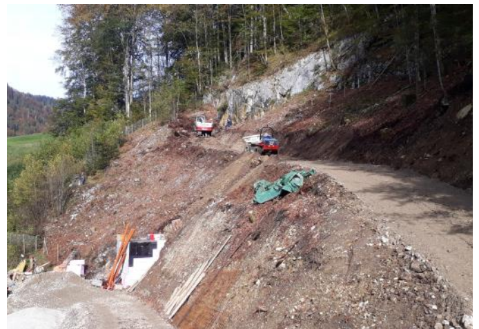
Um die Quelfassung unterhalb der Felsmauer errichten zu können, musste ein Zufahrtsweg hergestellt werden.
