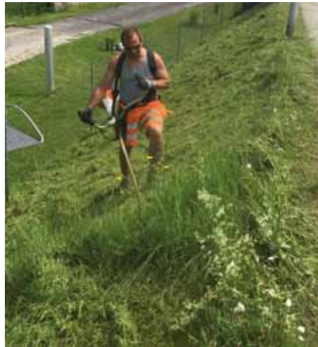
Viele Mäharbeiten können aufgrund der Hangneigung nur händisch erfolgen.
