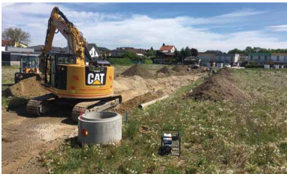
Neuerlegung von Wasser- und Kanalleitungen im Zirbenweg und der Wirtschaftszeile Süd.
