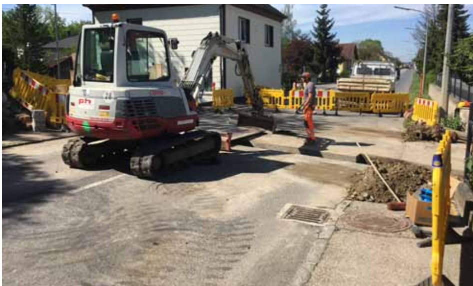
Sanierung der Wasserleitung auf der Mauthausner Straße.
