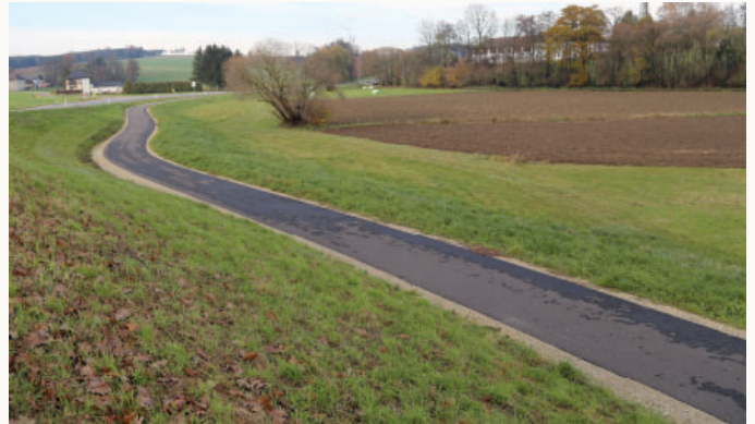
Radweg - Wallseerstraße bis Gotzing
