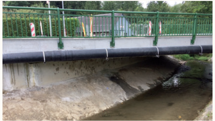
Trinkwasserleitung - Querung am Zierbach
