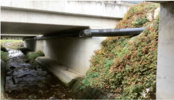
Trinkwasserleitung - Querung Berglandmilch
