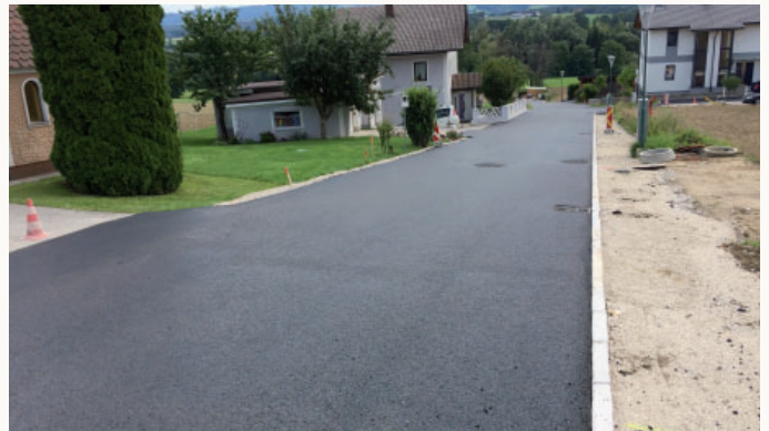
Asphaltierung Erlenweg (Krenstetten)
