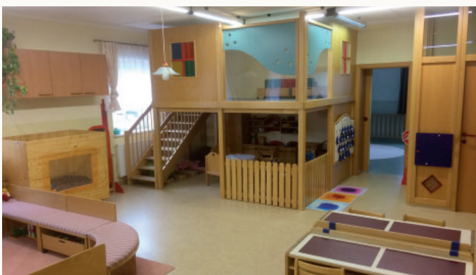
Sanierung des Gruppenraumes im LKG Krenstetten
