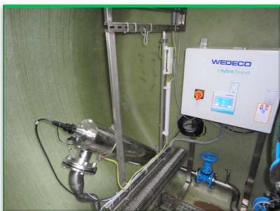
Die im Jahr 2001 errichtete Wasser-versorgungsanlage für die Ortsteile Dirnbachgraben und Ungermühle wurde Anfang September mit einer neuen UV Desinfektionsanlage ausgestattet.
