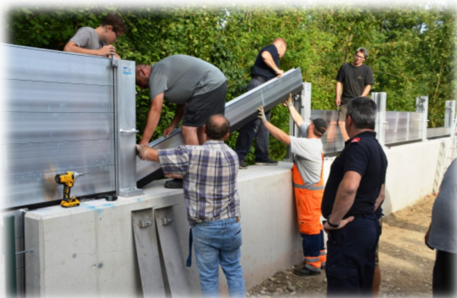
Probeaufbau Mobilschutzelemente durch beide Feuerwehren
