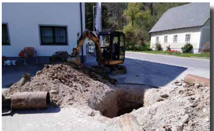
Sanierung Maibaumverankerung
