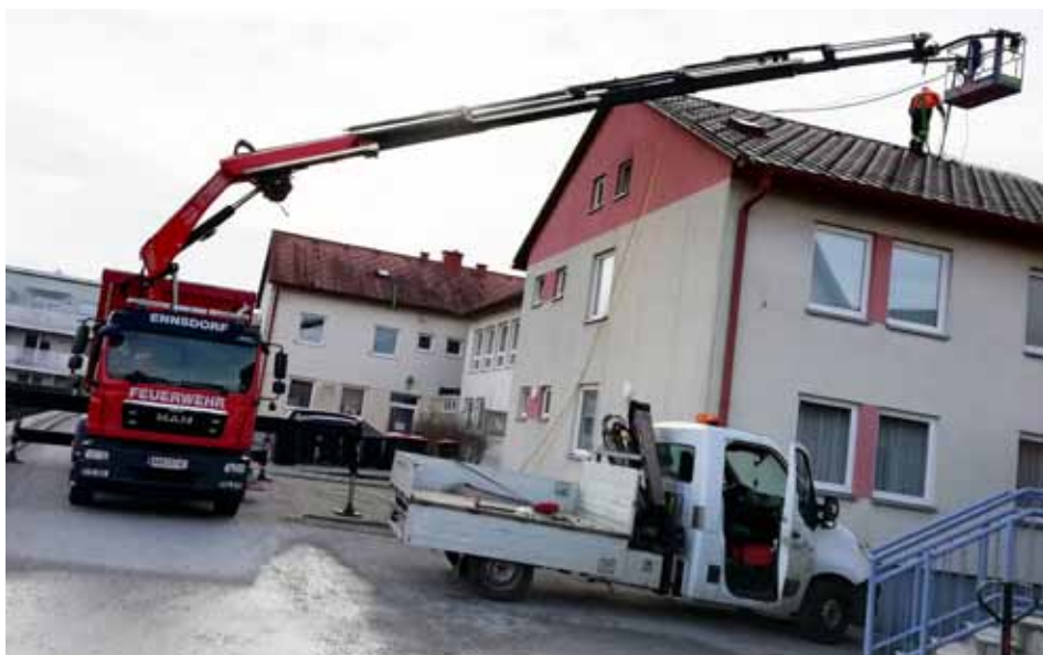
Franz Puchner und Andreas Lang reinigten die Dach- und Fassadenflächen.
