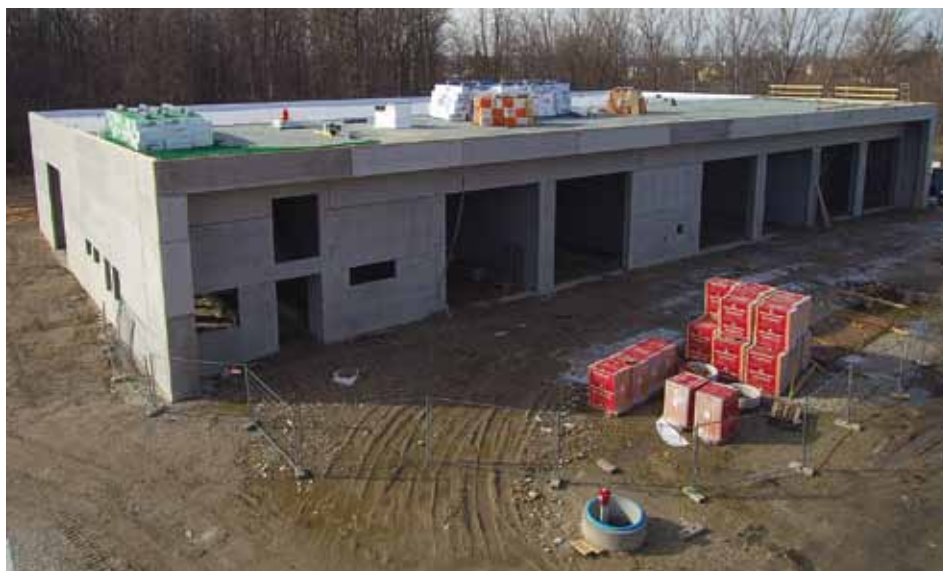
Der aktuelle Baufortschritt.
