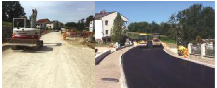
Landesstraße in Graben vor und nach der Fertigstellung der neuen Straße.
