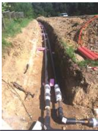
Die Leitung der Fernwärme wurde in Allhartsberg erweitert.
