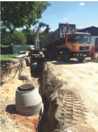
Beim Kindergarten in Kröllendorf wurde der Regenwasserkanal und die Wärmeversorgungsleitung verlegt.
