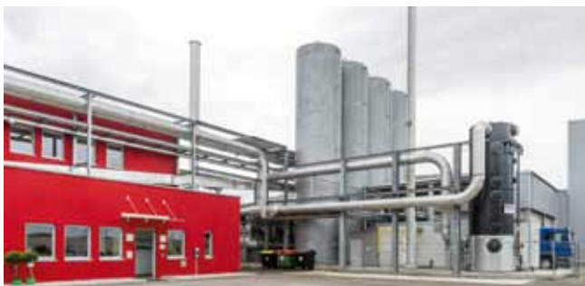
Bild: Das neue Donaupresswerk der Firma VFI
