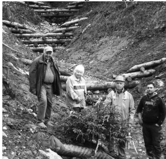
Familie Kohlert als Anrainer besichtigte die Baustelle im Kindlehengraben im Bild mit Michael Tippelreiter von der Wildbach- und Lawinenverbauung NÖ West.
