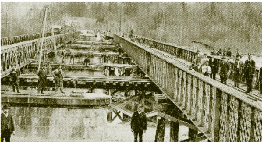
Wiedererrichtung der Eisenbahnbrücke als Stahlkonstruktion. Man war sichtlich stolz auf diese Ingenieursleistung, wie man der Grußkarte ganz unten entnehmen kann.
