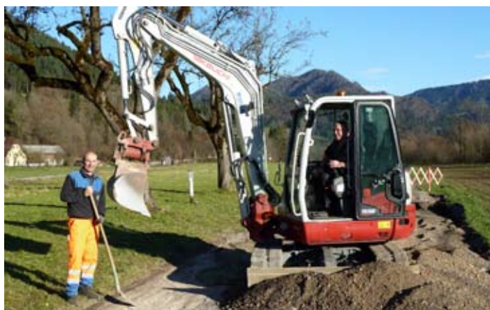
Rückbau EK Düker
