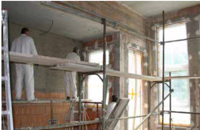
Ab 6. 5. steht unsere Baustelle für eine Woche ganz im Zeichen des Innenputzes.
