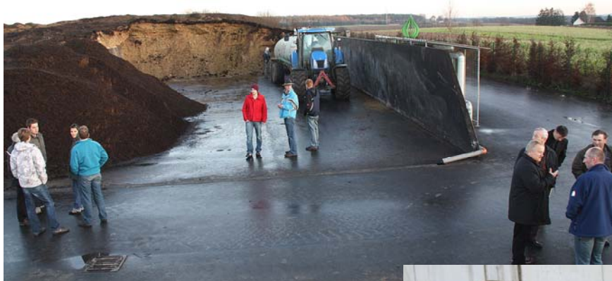
Biomasselager bei der Biogasanlage
