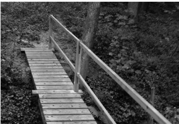
Foto: Die bereits in die Jahre gekommene Holzbrücke über den Eitzenbach wurde durch diese neue Brücke ersetzt.
