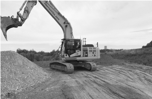
Foto: Mit der Firma Hinterholzer wurde eine Kooperation zur Dammverbesserung für Ardagger Markt eingegangen.
