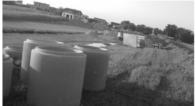
Foto: Bauzustand bei der Kanalverlegung in der Christophorusstraße in Stephanshart.
