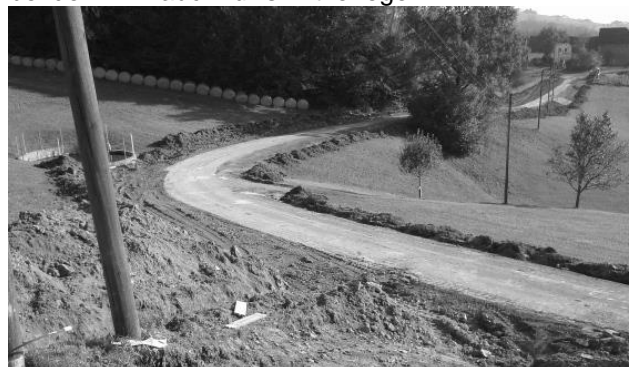
Foto: Neubau der Güterwegzufahrt Innerzaun III in Kollmitzberg.
