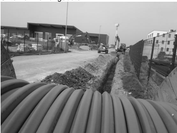
Foto: Verlegung der Glasfaser-Lehrrohre im Betriebsgebiet Amstetten-Nord.
