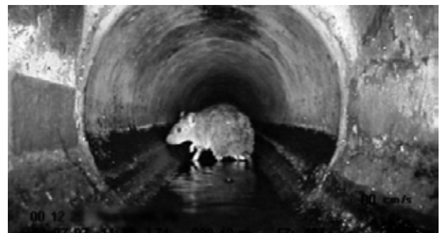
Foto: Speise- und Essensreste im Kanal fördern die Vermehrung von Ratten!
