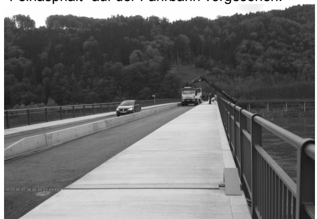
Foto: Die Sanierung der Greiner Donaubrücke erfolgt soweit plangemäß.
