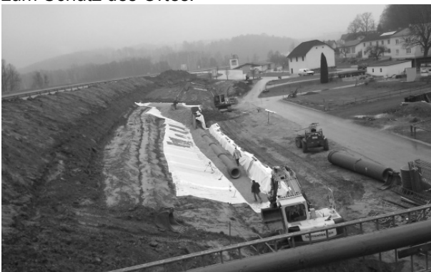
Foto: Baustelle beim Hochwasserschutzdamm Ardagger Markt.
