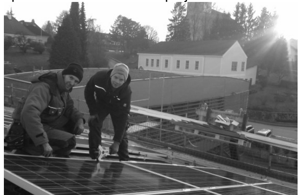
Foto: Arbeiter der Fa. Hörmann bei der Installation der Photovoltaik-Anlage am Moar-Haus-Dach.
