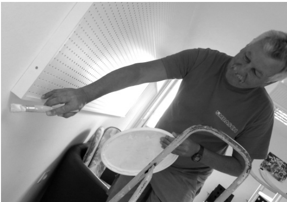
Foto: Einer der fleißigen Helfer Klaus Hartl bei den Arbeiten im Rahmen des Gemeinschaftsraumes.
