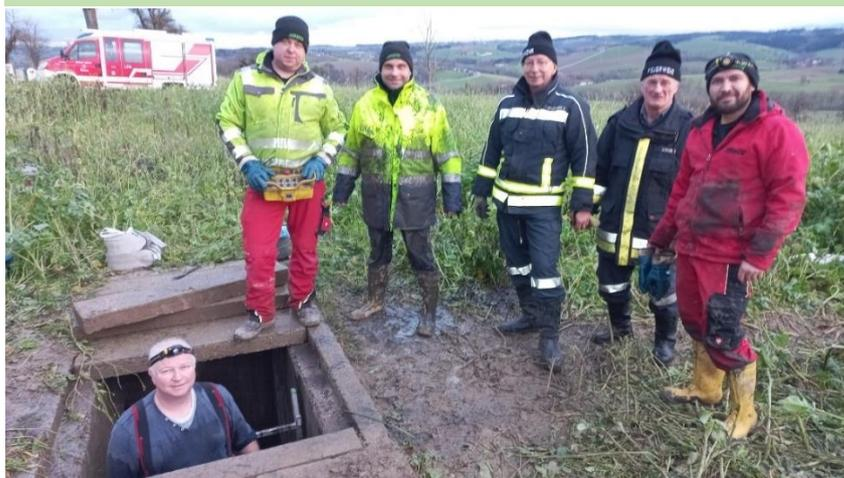
Um die Wasserzisterne auf der Hub wieder zu aktivieren, wurde diese ausgepumpt und gereinigt. In weiteren Schritten wird die Zisterne wieder mit Wasser gefüllt werden und für Notfälle bereitstehen.
