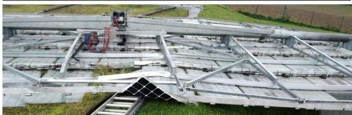
Der umgestürzte PV-Tracker nach dem Sturm - ein Totalschaden.
